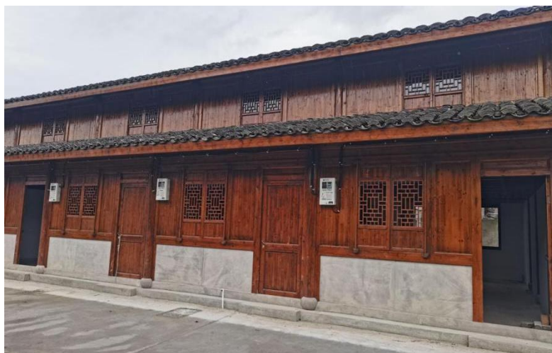
凤南三弄古建筑修复工程
