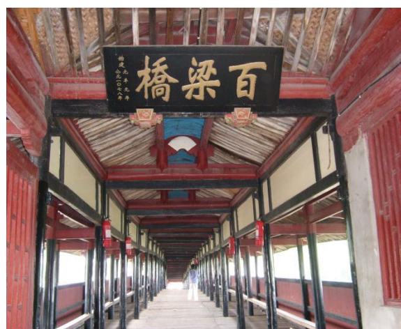
百梁桥内部图片
