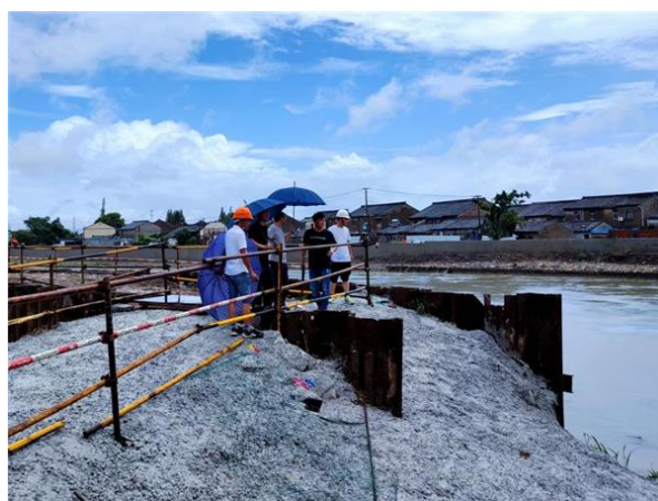
鄞江堤防施工现场
