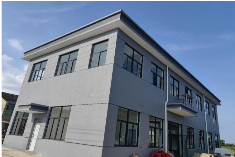
砖瓦厂改造后
