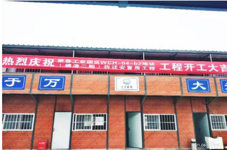
2021年横港二期拆迁安置房工程开工
